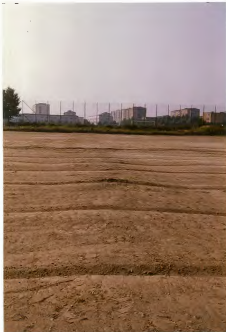
Figur 3. Packad yta. Upphöjningen är orsakad av en kvarlämnad grundmur.
