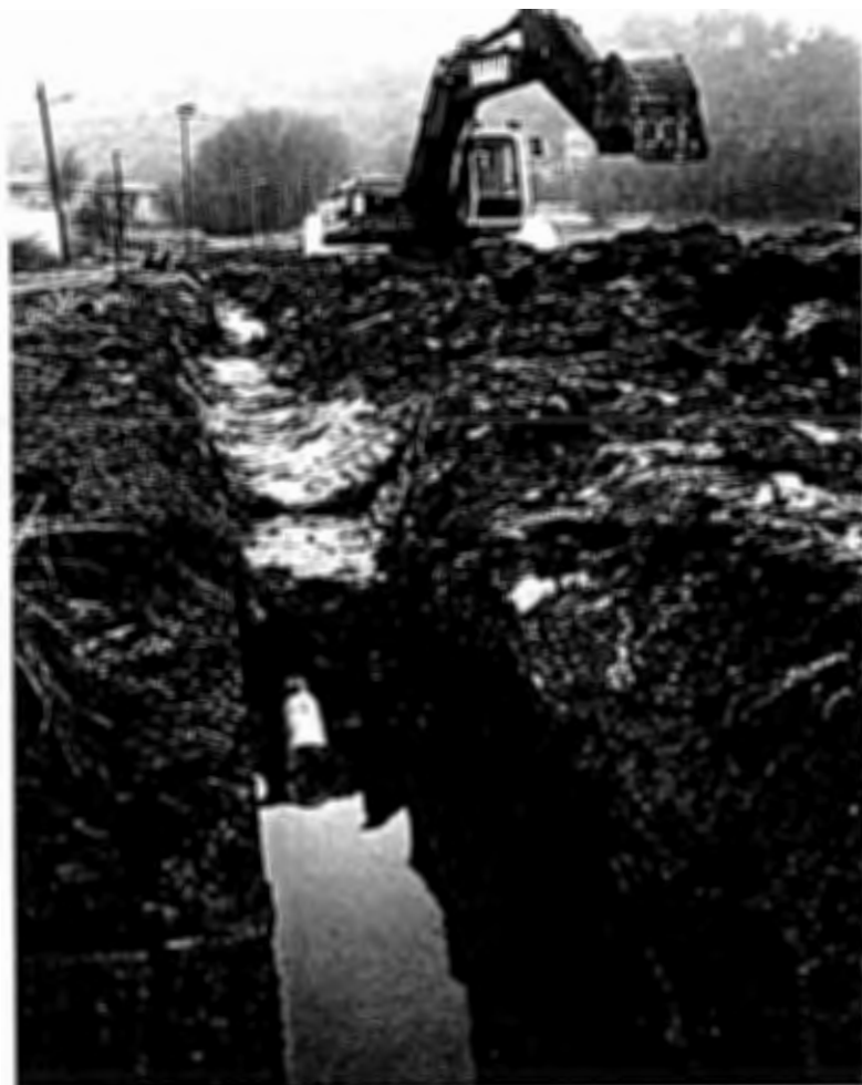
Fig 1. Fotot visar fortsättningen på den "plöjda gasledningen" utförd med konventionell schaktning.
