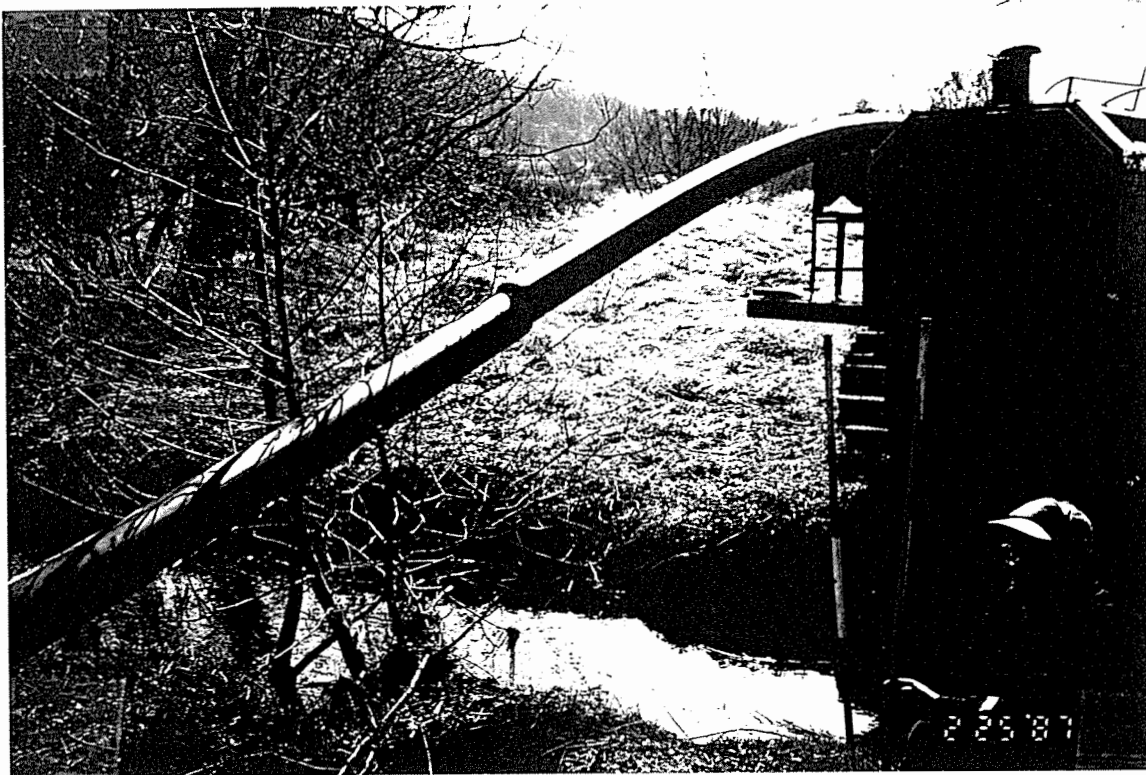
Fig 4. Plöjning över korsande bäck, skyddsror i form av PEM-rör dy 200 mm används.
