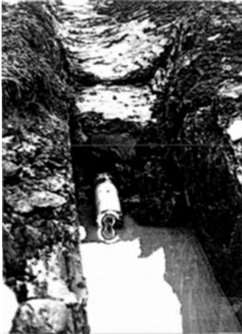
Fig 5. Konventionell schaktad ledningsläggning där man hade vissa problem med vatten i schakten.
