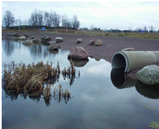
Figur 2.7 Exempel på sedimentationsanläggning för rening av vägdagvatten.
