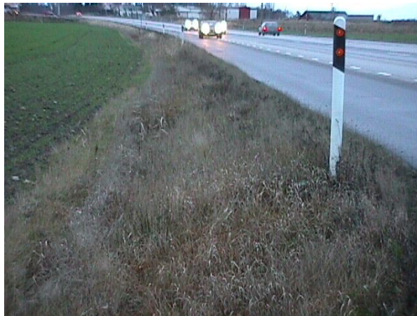
Figur 2.2 Exempel på dike som inte bara avvattnar vägbanan.
