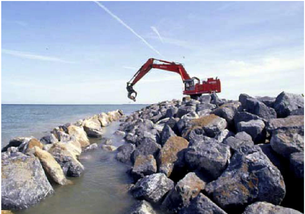
Figur 3.1 Exempel på produktionssätt för vågbrytare med sprängstensbeklädad.
