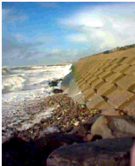
Figur 3.4 Illustration av uppspolningsnivå. Strandskonings höjd måste anpassas till risken för överspolning. (Bild: Karin Odén)
